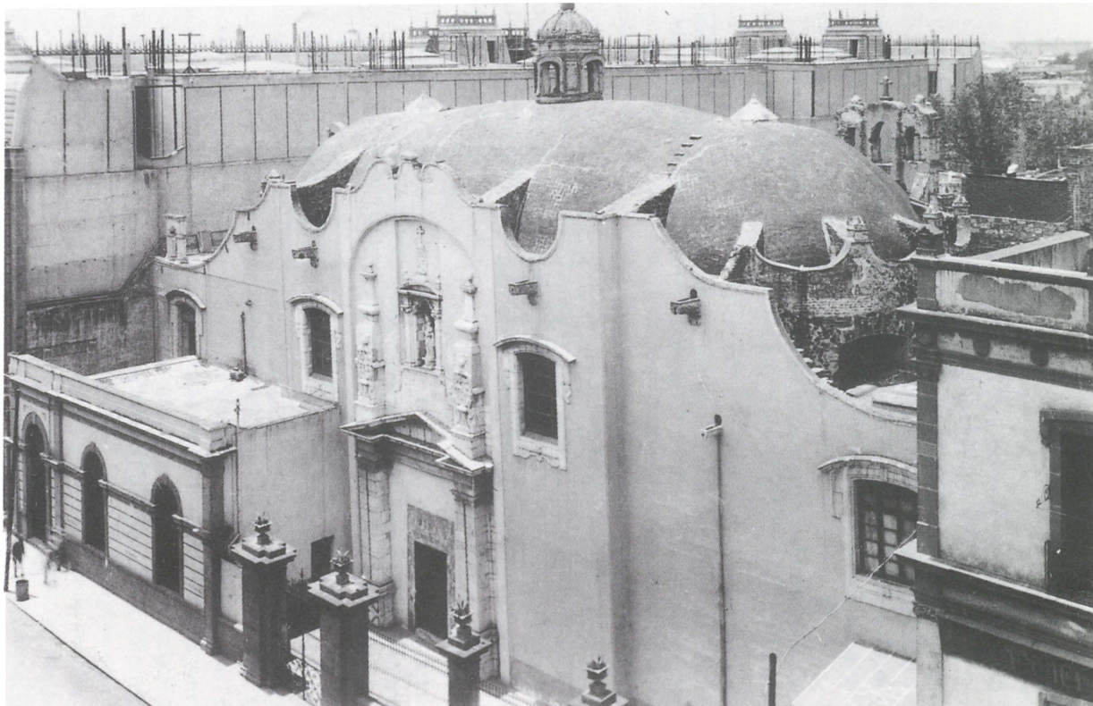
Iglesia del convento de Santa Brígida con una sacristía añadida al frente en el siglo XIX. Fototeca del Instituto de Investigaciones Estéticas, UNAM
